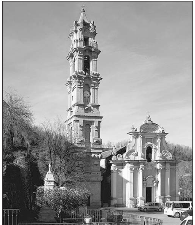
Toiture abîmée, infiltrations, lézardes, la restauration de l'Eglise St Jean-Baptiste est une vraie urgence.
